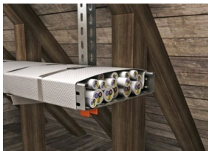
Slika 25: Bandažirana trasa v lahko vnetljivem okolju
