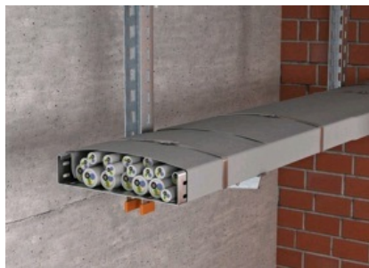
Slika 21: Bandažirana kabelska trasa, obešena na strop
