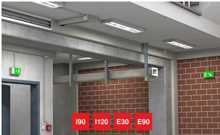
Slika 13. Ognjevarni kanali PYROLINE® ConD in ConS iz lahkega porobetona
