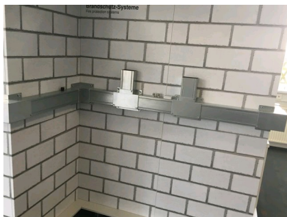
Slika 3: Montaža neposredno na zid
