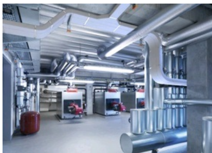
Slika 24: Bandažirana trasa v proizvodnih prostorih
