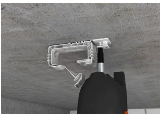
Slika 9: Strojno pričvršćivanje na strop
