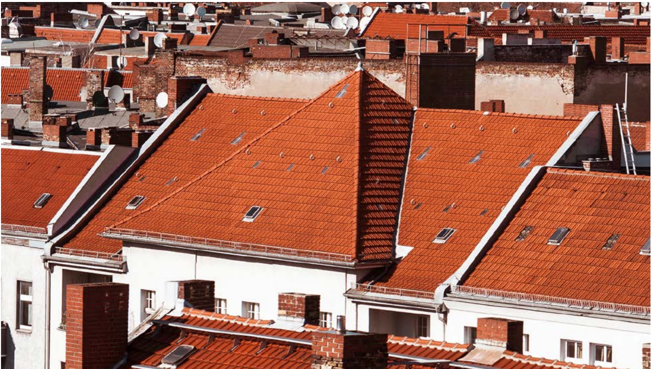
Brandwände verhindern eine Brandausbreitung
